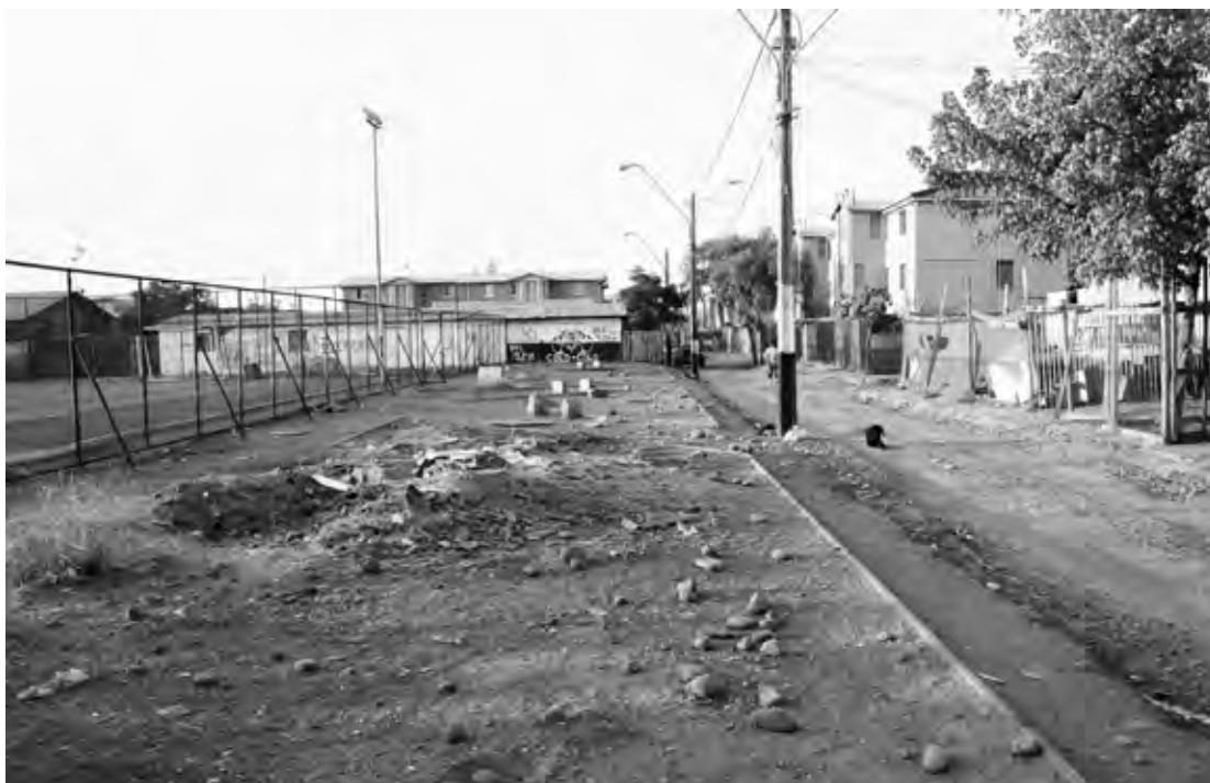
FOTO: MINISTERIO DE LA VIVIENDA Y URBANISMO DE CHILE
