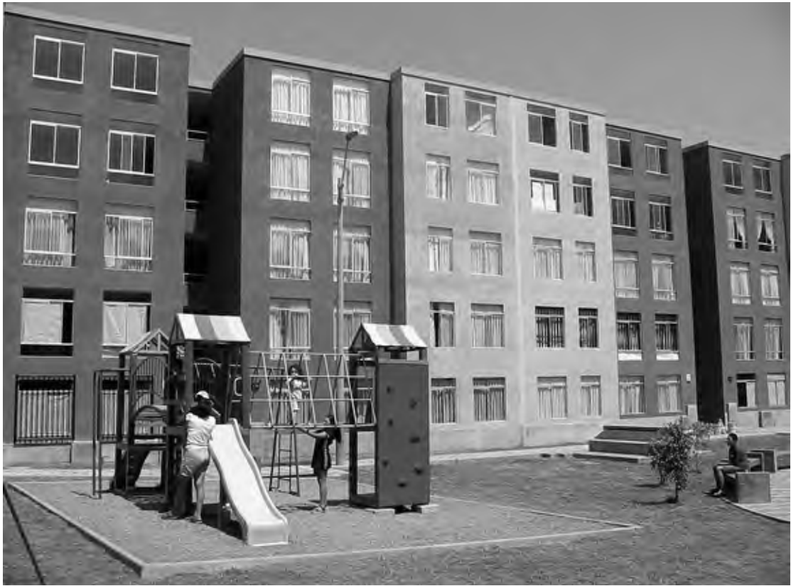
FOTO: MINISTERIO DE VIVIENDA, CONSTRUCCIÓN Y SANAMIENTO DEL PERÚ
