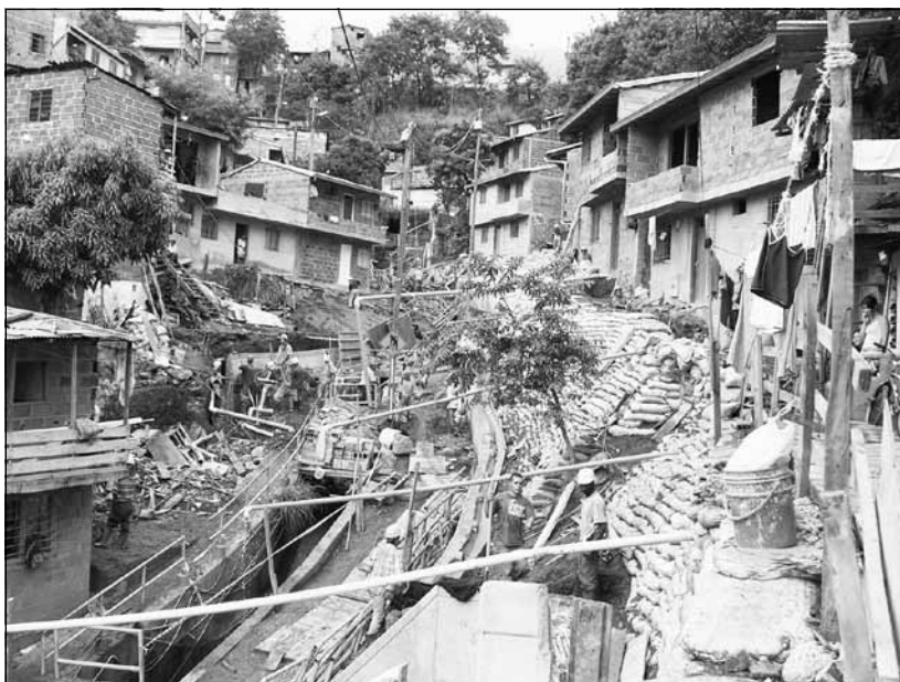
En esta imagen se observa el proceso de edificación de las viviendas sobre la quebrada Juan Bobo (EDU, 2008).
