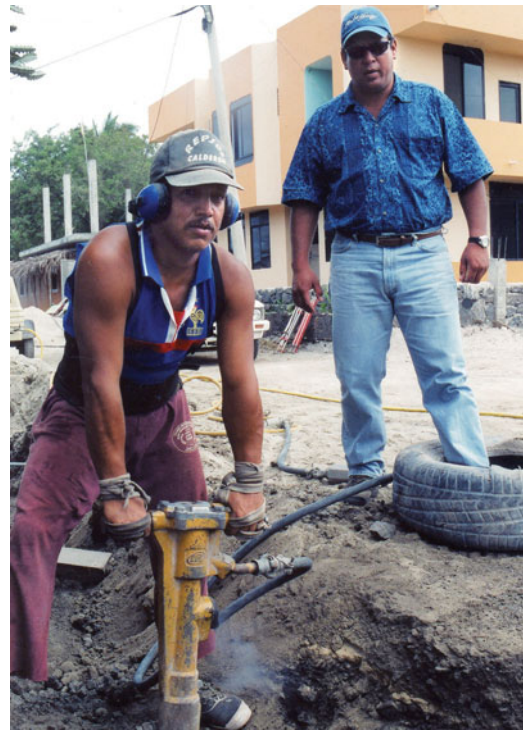
El alcalde Gordillo inspecciona el avance de las obras de un sistema de alcantarillado en Puerto Villamil.
