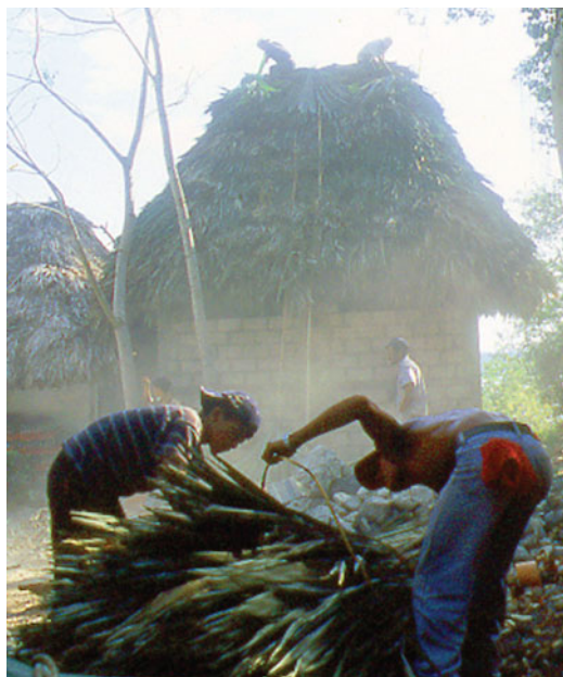
Ramas de palma son el toque final que transforma unos modestos servicios sanitarios en auténticas réplicas mayas.
