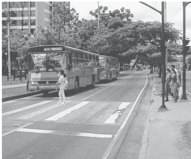
Foto 16. Pista exclusiva de la Av. Cristiano Machado, en Belo Horizonte. Los semáforos regulan el cruce de los peatones y las vallas impiden que lo hagan fuera de la zona señalizada para ese fin.
