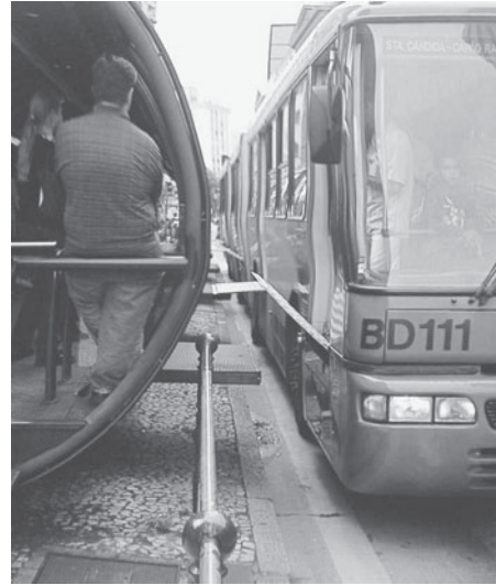
Foto 10. Funcionamiento de la plataforma de autobús de Curitiba. Cuando el vehículo llega a la parada, el conductor acciona un puente entre el autobús y el andén de la estación-tubo, permitiendo el embarque y desembarque a nivel.
