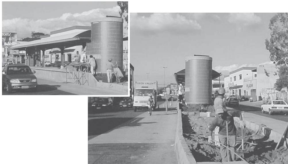
Fotos 3 y 4. Estación de transferencia de la Av. Sertorio, en Porto Alegre. Terminal de transferencia para operación de autobuses con puerta a la izquierda y carril exclusivo en construcción.
