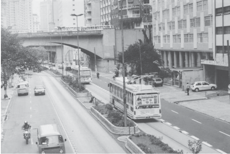
Foto 24. Av. 9 de Julio en São Paulo. Un solo carril exclusivo para los autobuses. Cámaras fotográficas controlan eventuales infracciones.
