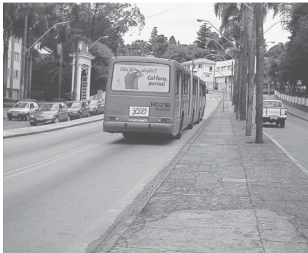
Foto 6. Eje estructural de Curitiba. Vía local de doble dirección, exclusiva para el transporte colectivo, complementada por dos carriles laterales.
