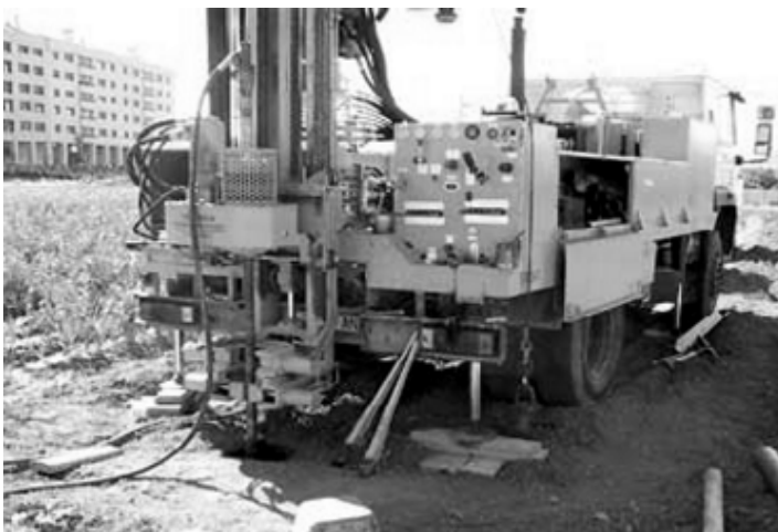
Figura 50 . Sonda de Rotación para la realización de sondeos de reconocimiento
