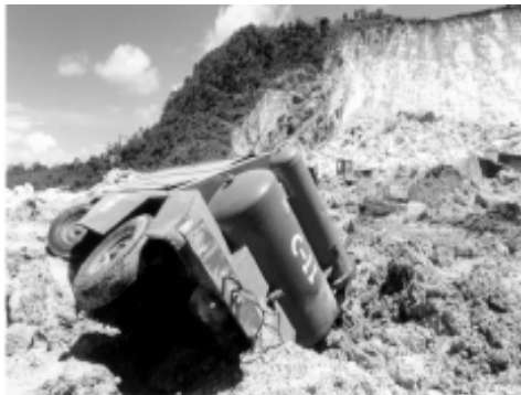
Figura 31. Inestabilidad de laderas ocasionada por actividades mineras a cielo abierto en sitios no aptos
