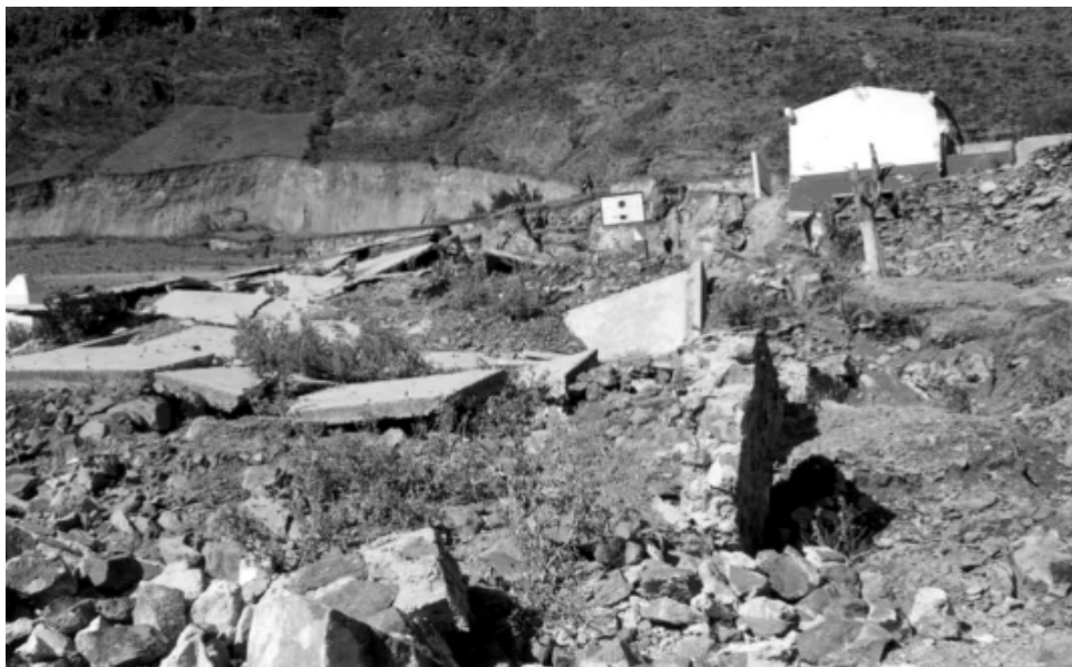
Figura 24. Destrucción total de la parte central del poblado de Miguel Hidalgo, Zapotitlán de Salinas, Puebla
