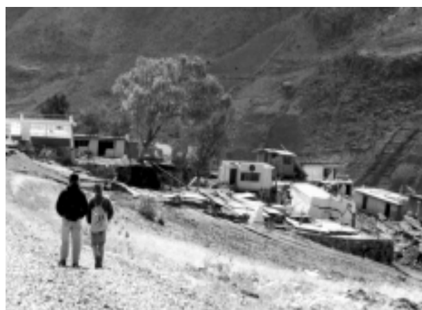
Figura 37. Parcial destrucción del poblado debido al deslizamiento
