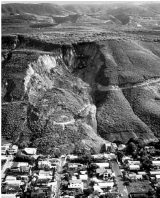
Figura 9. Deslizamiento rotacional la Conchita, en California
