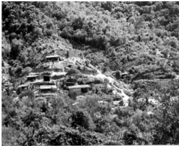
Figura 33. Los asentamientos humanos irregulares alteran las condiciones de estabilidad de una ladera natural al generar cortes, conformar terrazas y devastar la vegetación
