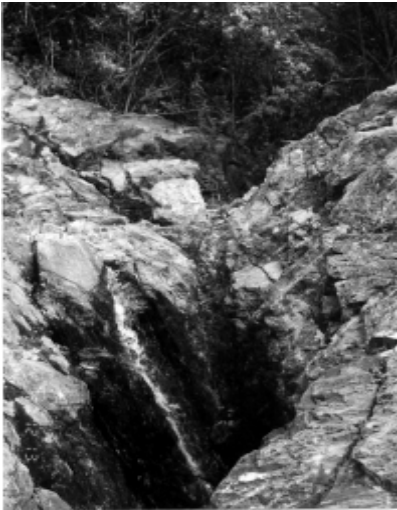
Figura 17. Las concentraciones de humedad en sitios que comúnmente no están saturados indican zonas de posibles movimientos. Durante lluvias intensas se origina una recarga que influye en la inestabilidad.
