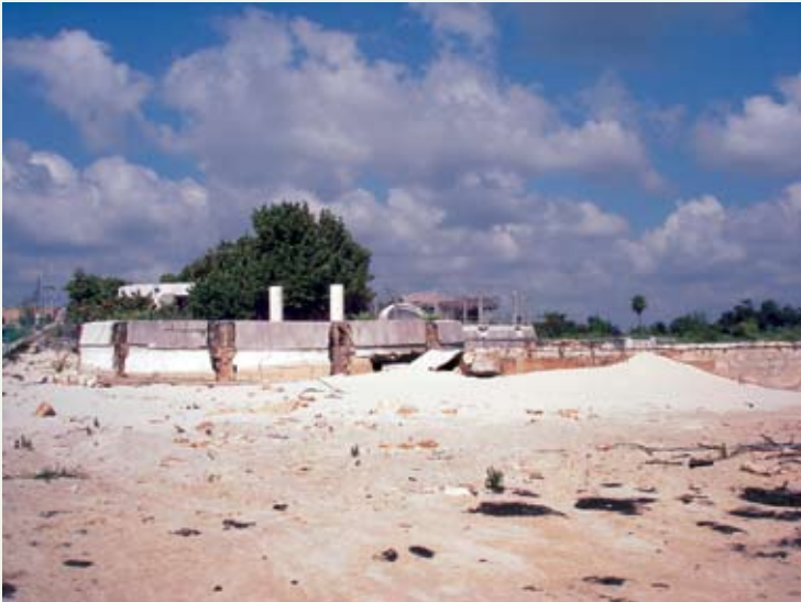
Figura 3.9 Daños ocasionados por el huracán Wilma en la costa de Quintana Roo.
