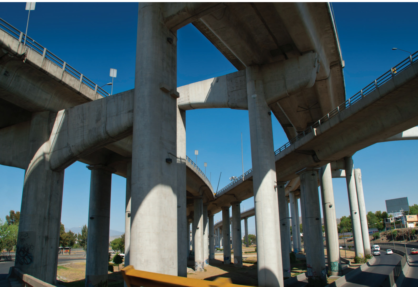
Distribuidor vial La Concordia, Zaragoza-Texcoco.
