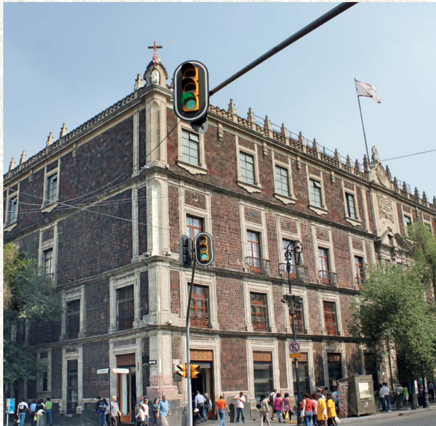
Vista general de la fachada
