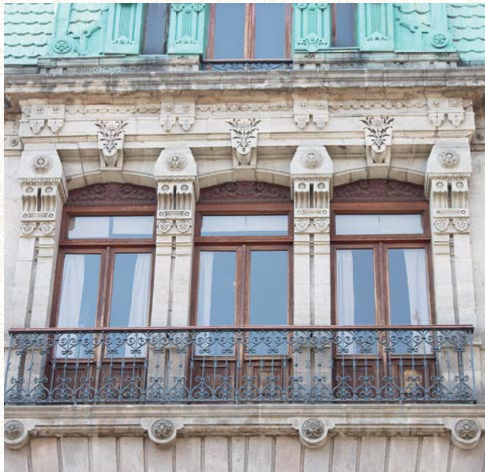
Detalle de ventana
