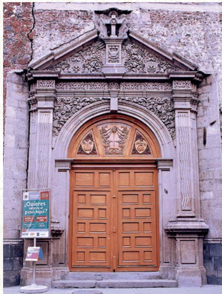
Detalle de puerta
