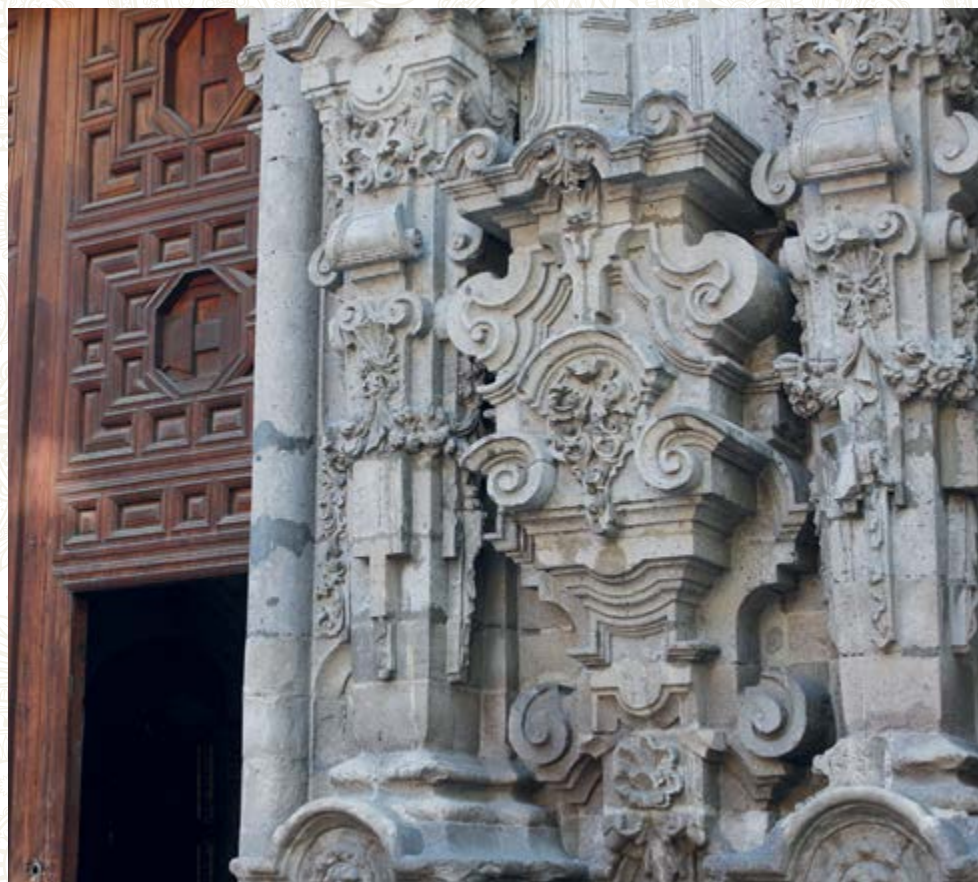
Detalle de fachada
