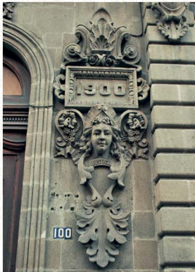
Detalle de la fachada
