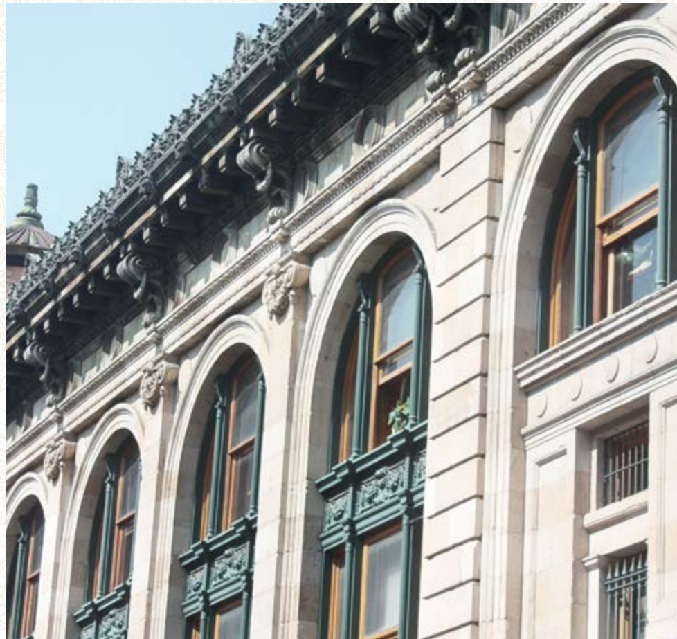
Detalle de ventanas
