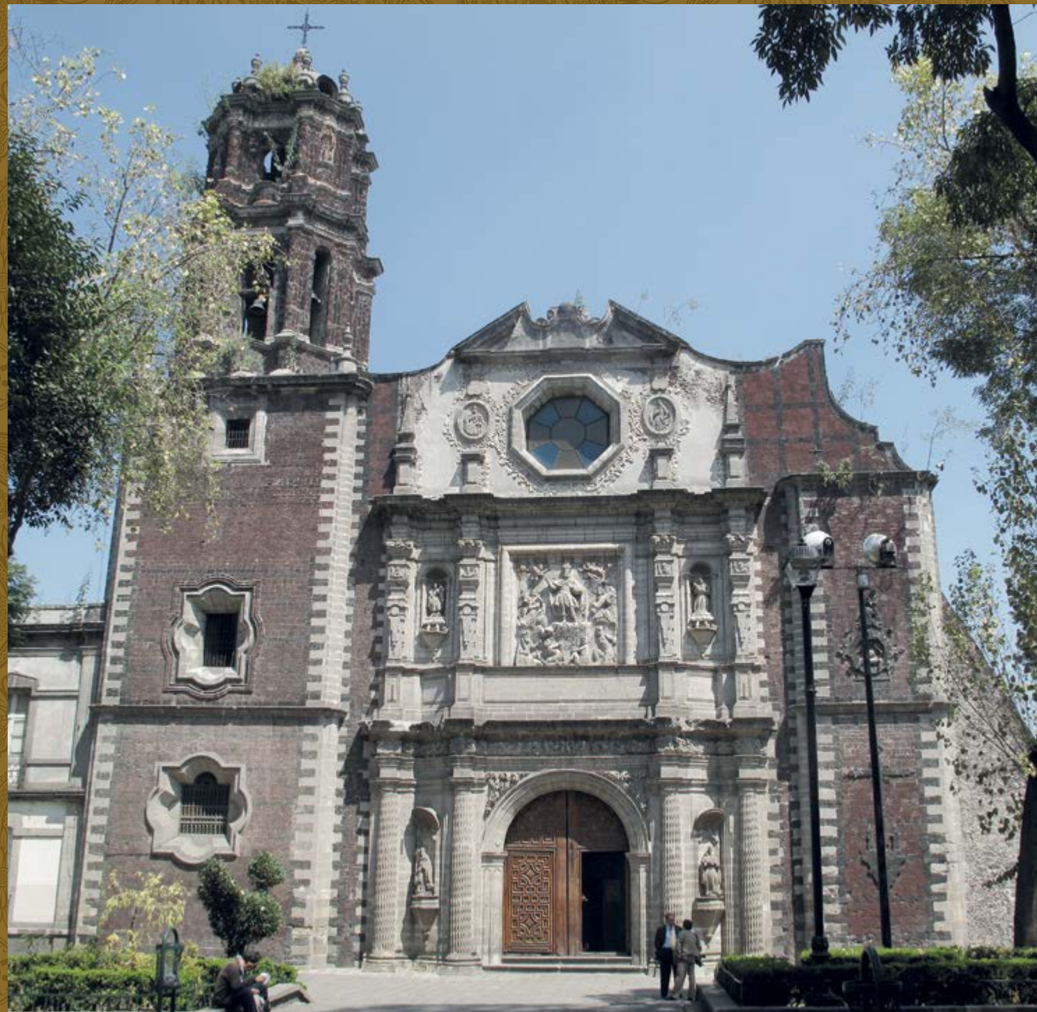
Vista de fachada principal
