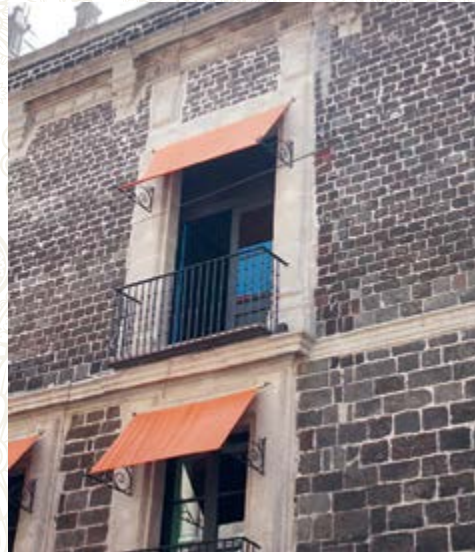
Balcones en la fachada
