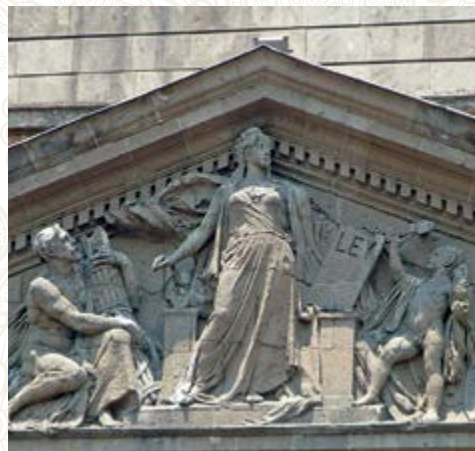
Detalle de la fachada.
