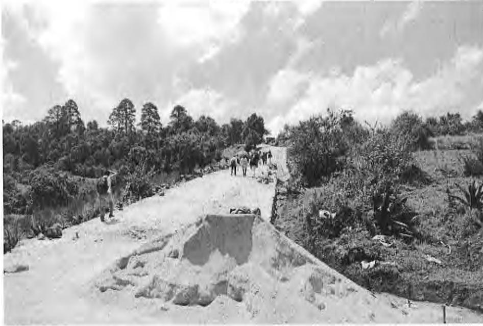
Foto 8. Construcción de caminos de penetración en la Zona Boscosa de San Pablo Oztotepec.
