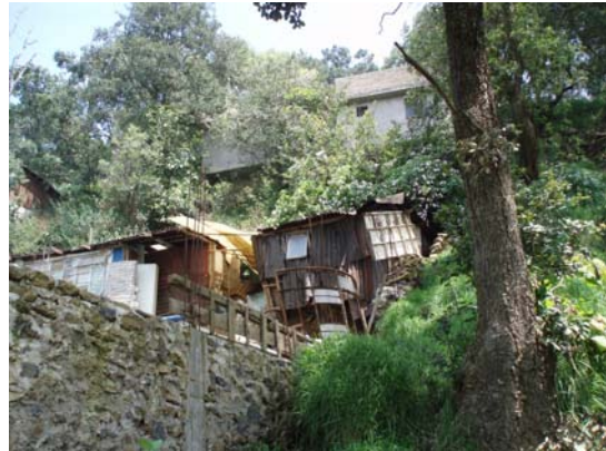
Foto 263. Construcción sobre talud, en riesgo de derrumbe y deslizamiento.
