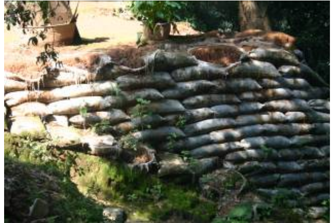
Foto 136.- Costaleras que sirven de soporte a las viviendas
