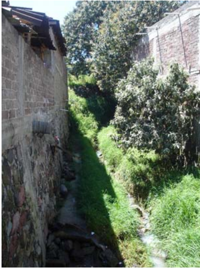
Foto 305. Viviendas construidas sobre el cauce natural
