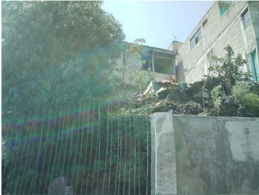
Foto 174.- Panorámica de la ladera en “Minas o Charcas” en la que se aprecia el asentamiento de viviendas en la parte alta, así como una parte de la construcción del muro de construcción.
