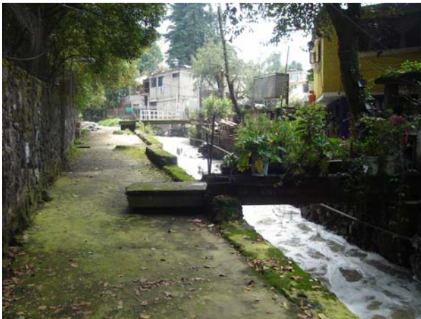
Foto 143. Asentamientos humanos irregulares ubicados junto al cauce del río, invadiendo Zona Federal.
