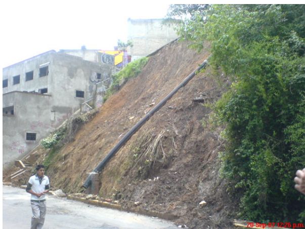
Foto 38. Deslave de talud con peligro de caer hacia la avenida y se presentan trozos de cimentación de una vivienda que se ubica en la parte alta.
