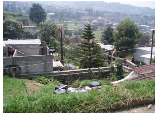
Foto 265. Construcciones de tabique, lámina y concreto sobre talud.
