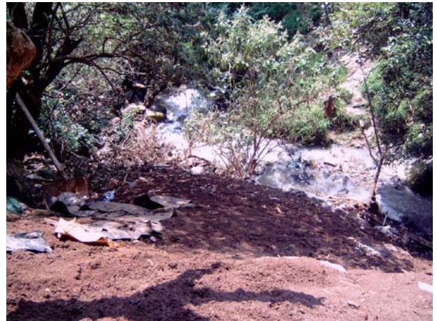
Foto 155. Relleno con cascajo, basura domestica y tierra natural en una ladera.
