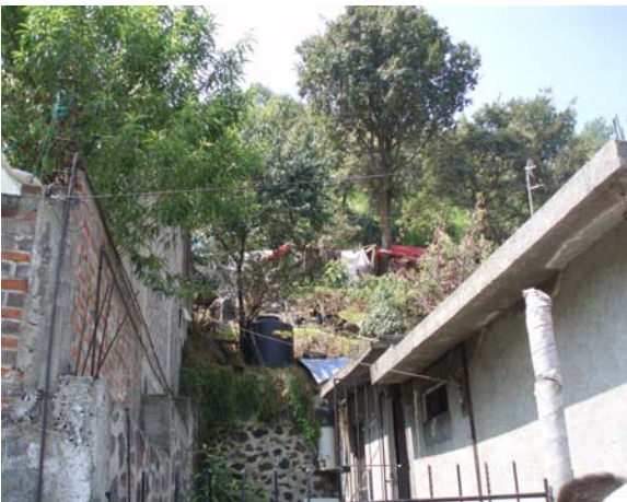
Foto 271. Construcciones formales de tabique y concreto.
