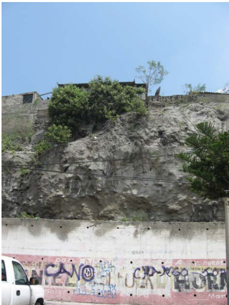
Fotos 239 y 240.- Vista de las dos laderas con las que colinda Cerrada San Pedro, mismas que tienen concreto lanzado como medida de mitigación.
