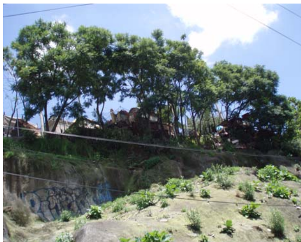
Foto 16. Árboles sobre el talud de la barranca con las raíces expuestas, y la presencia de deslave por aguas pluviales.
