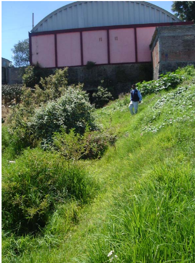
Foto 311. Equipamiento deportivo construido sobre el cauce.
