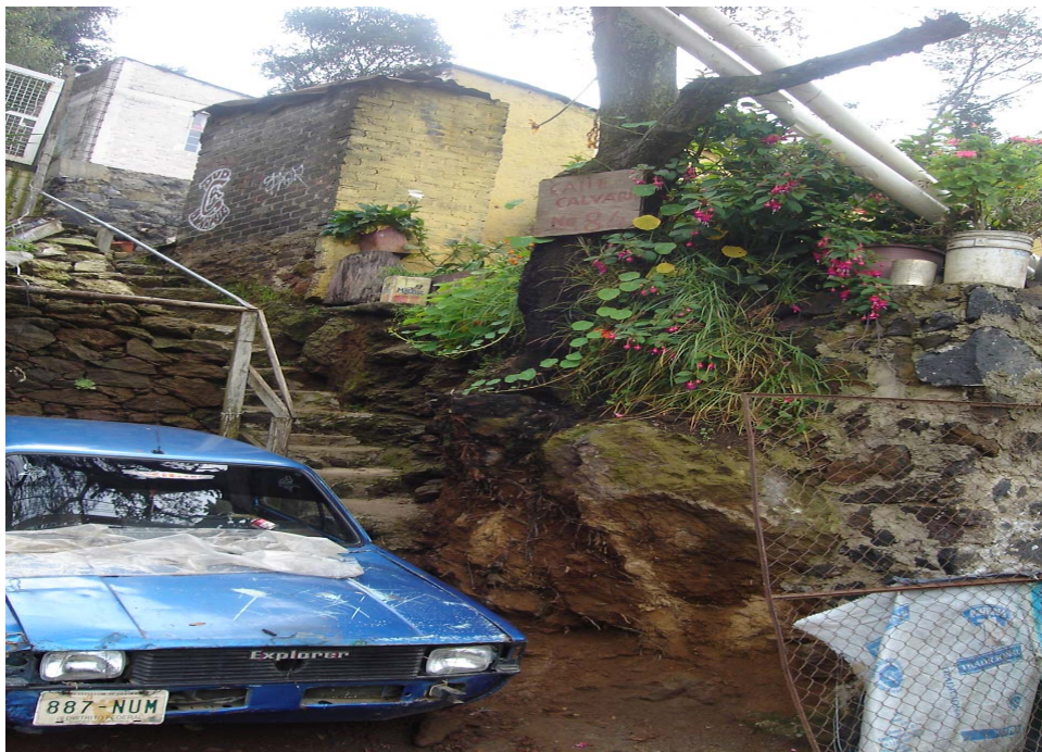
Foto 274.- Árbol con corte de raíces a la entrada del número 84 de la Calle Calvario, por corte de talud.
