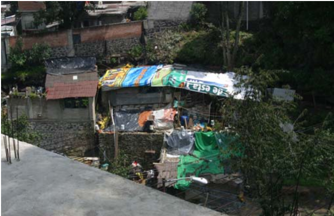
Foto 156. Por la construcción en laderas pronunciadas, se ha propiciado al desgaje de la tierra, ocasionando la zona de alto riesgo
