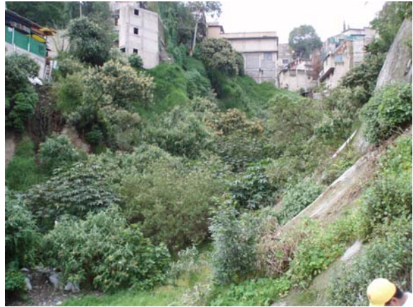
Foto 18. Los deslaves de talud provocan que las raíces de los árboles queden expuestas.
