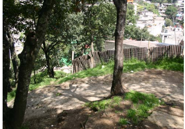
Foto 29. El deslave descubre las raíces de los árboles que se encuentran cerca de las viviendas de dicho asentamiento.
