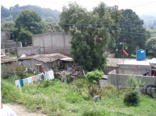
Foto 264. Construcciones con afectación por descargas y acumulación de residuos.
