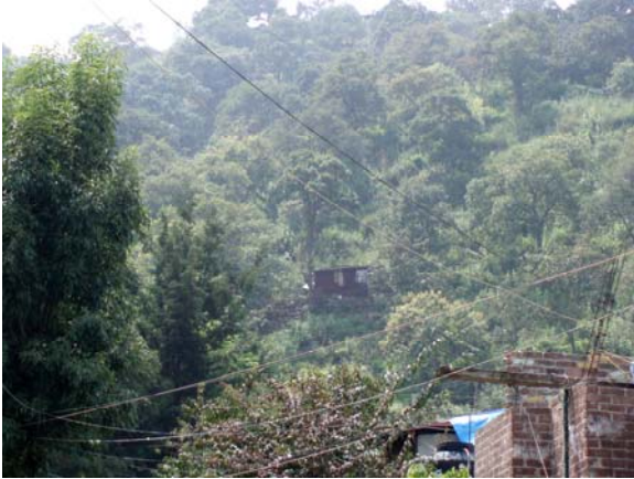
Foto 259. Viviendas precarias sobre pendiente
