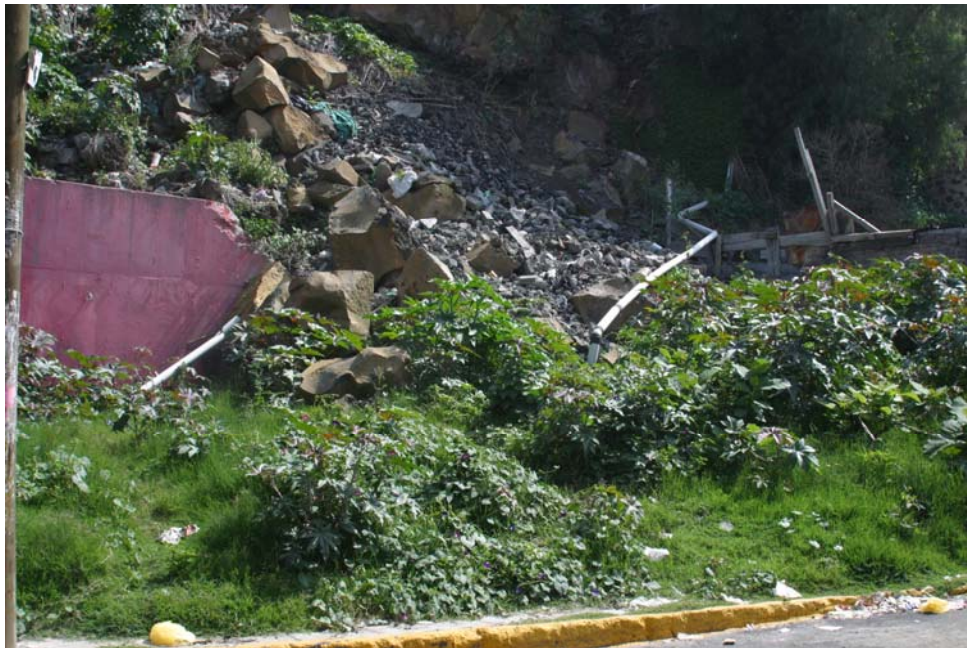
Foto 198.- Residuos sólidos producto de una demolición
