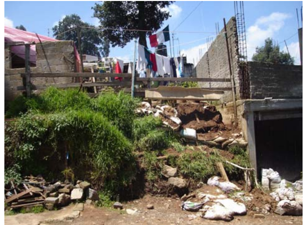
Foto 147. Vivienda sobre la ladera y en algunos casos se utilizan costaleras a fin de mitigar el deslave del terreno.
