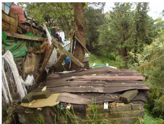
Foto 276.- Viviendas asentadas en talud, sin muro de contención
