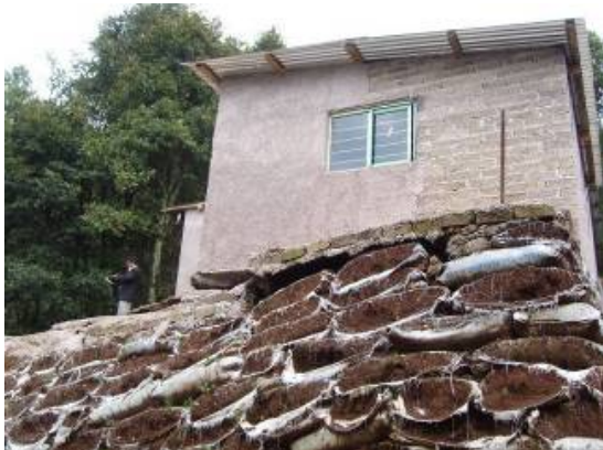
Foto 68.- Viviendas construidas sobre costaleras
