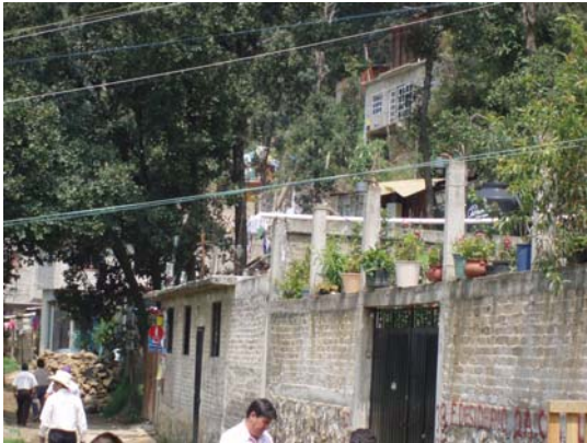
Foto 262. Construcción sobre pendiente abrupta.
