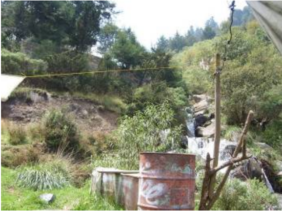
Foto 72.- Vivienda en la que se aprecia el río en bajada. Este es un elemento de alto riesgo, debido a que en una crecida del río además de inundar el área en la que se ubica la vivienda, trae consigo materiales tales como troncos y rocas.
