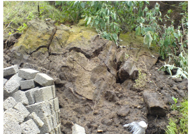
Foto 43. Se observan restos de material de suelo e un talud que se deslavo.
