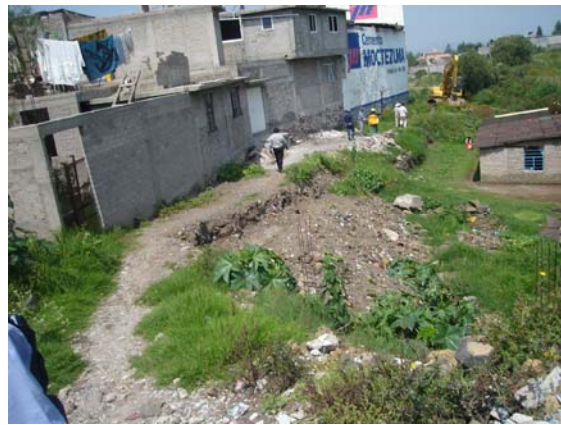
Foto 298. Depósito de tierra y ubicación de las viviendas cercanas al cauce.
