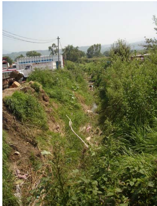
Fotos 307 y 308. Viviendas construidas cercanas al cauce natural y falta de limpieza del mismo.
