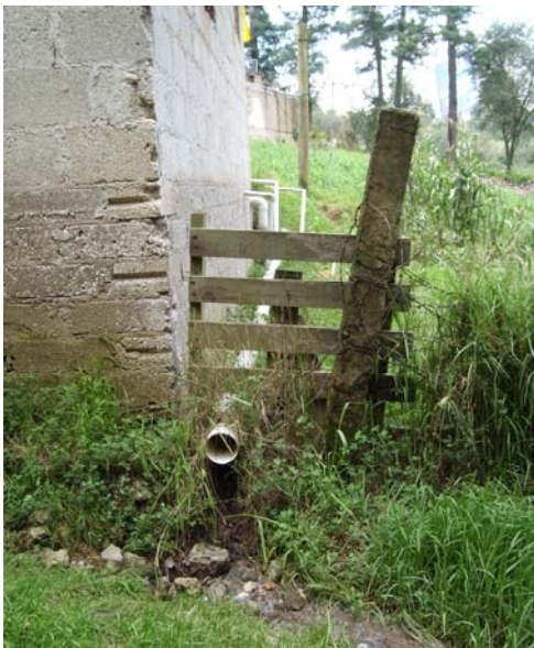
Foto 87.- Tubería de PVC que transporta aguas residuales y acumulación de residuos sólidos
