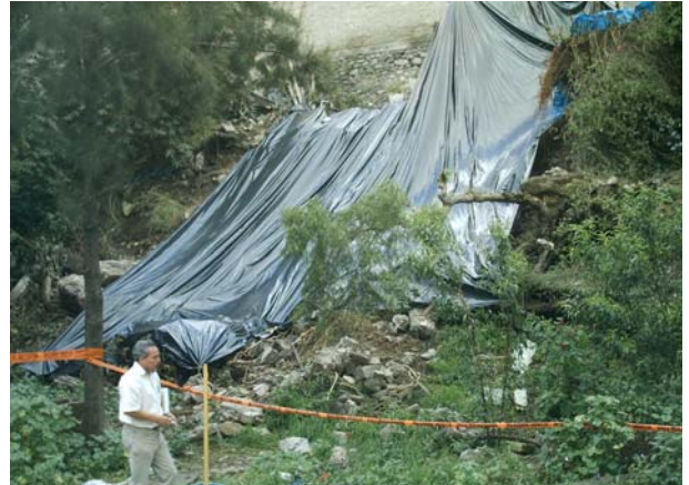
Foto 20. Deslave de talud arrastrando material con rocas y algunos árboles.
