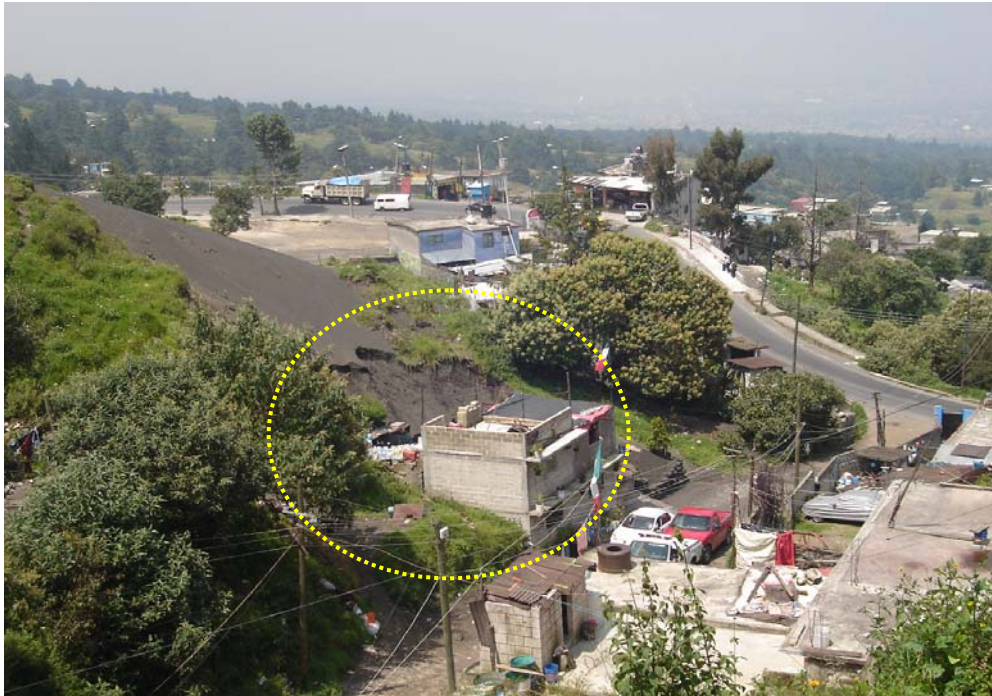
Foto 273.- Muestra a una de las viviendas que constantemente le cae material (arena), producto de lo inestable de la ladera
