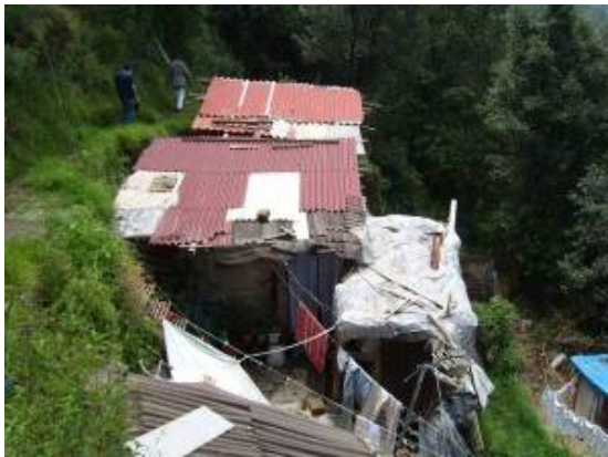
Foto 58.- Viviendas ubicadas en laderas sobre taludes
