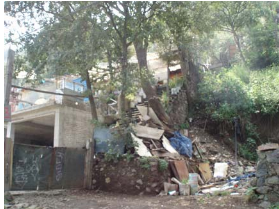
Foto 260. Viviendas precarias sobre pendiente.
