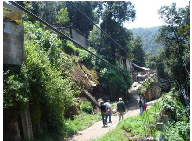
Foto 149. Viviendas ubicadas en laderas sobre taludes, con sistemas constructivos inapropiados.
