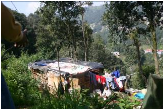
Foto 139.- Las viviendas ubicadas en esta zona están construidas en su mayoría con madera y lámina
