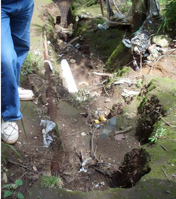
Foto 87.- Tubería de PVC que transporta aguas residuales y acumulación de residuos sólidos
