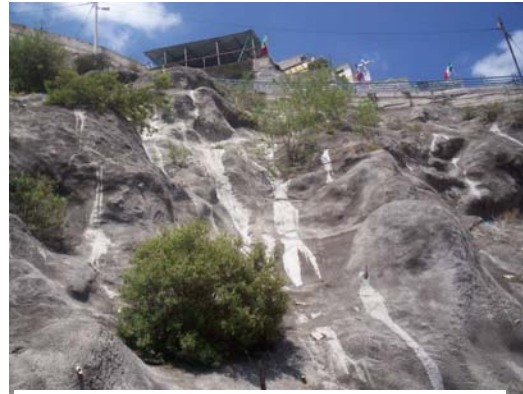
Foto 161. Colonia Malacates. Se observa el revestimiento a base de concreto sobre el talud.
