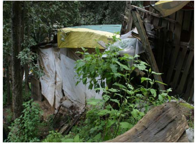
Foto 153. Asentamientos humanos con construcciones provisionales, con materiales como lámina de cartón, lonas, láminas y madera.
