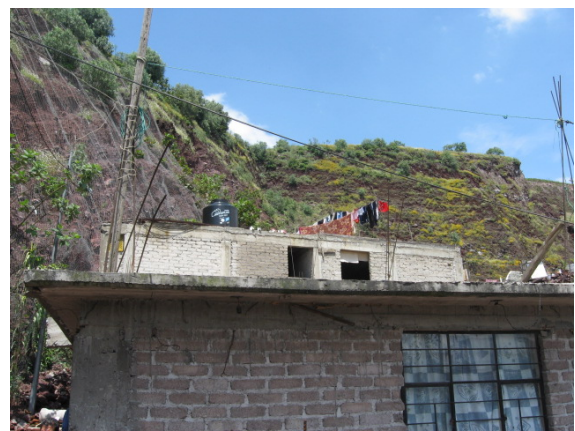
Fotos 231 y 232.- Inmueble de alto riesgo ubicado en un talud de la ladera del cerro.
