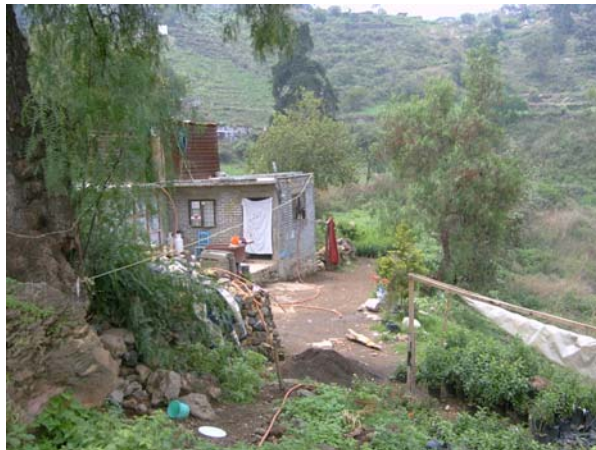
Foto 261. Zona de alto riesgo debido a que se presentan desprendimientos de rocas y arrastre de materiales.
