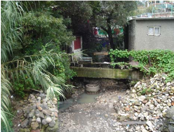
Foto 141. Asentamientos humanos irregulares ubicados junto al cauce del río, invadiendo Zona Federal
