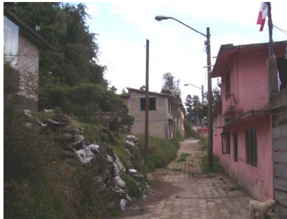
Foto 93.- viviendas ubicadas en la parte baja de la ladera.
