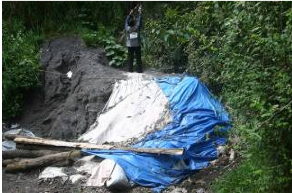
Foto 123.- Parte de un talud cubierto con plástico para evitar su continua impregnación de agua
