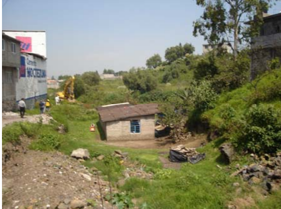
Foto 299. Viviendas ubicada en el interior del cauce
