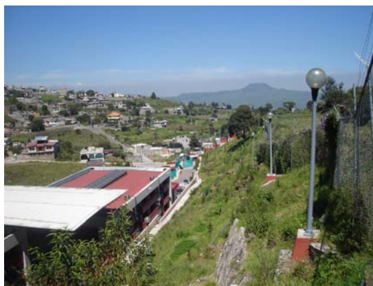
Foto 288. Preparatoria ubicada en la parte baja de la barranca y construida sobre el cauce natural.
