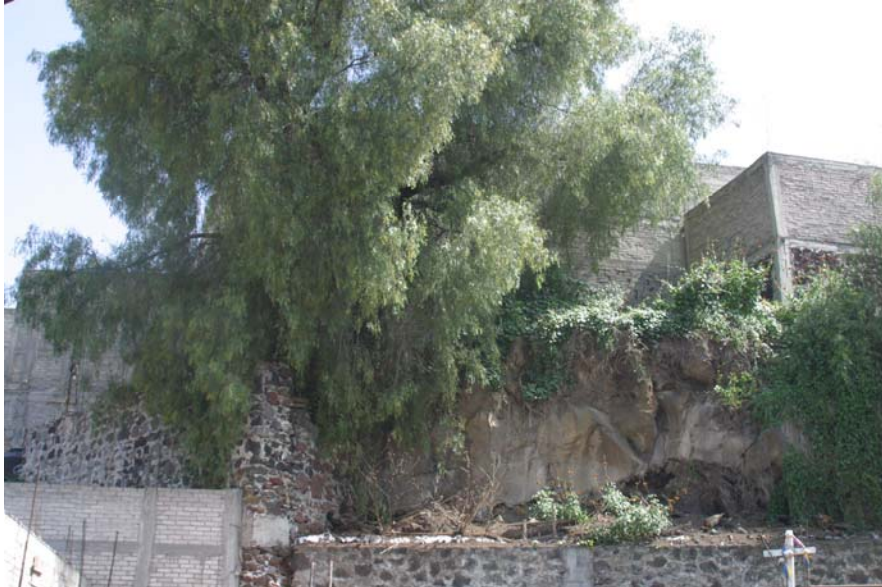
Foto 197.- Vivienda construida sobre una roca
