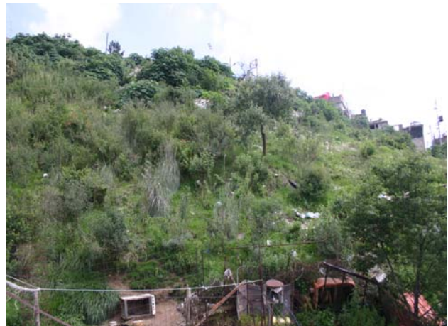
Foto 27. Asentamiento desplantado sobre ladera sin trabajos de estabilización se observaron 5 viviendas las cuales están habitadas por 50 personas.
