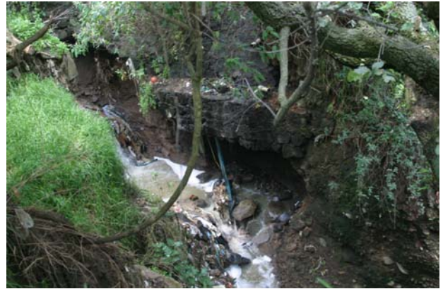
Foto 151. Acumulación de residuos sólidos de manejo especial (cascajo) sobre el cauce.
