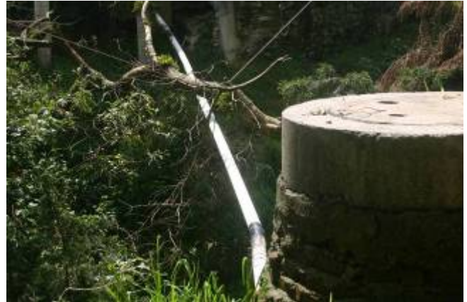
Foto 114.- Ductos de drenaje a los colectores
