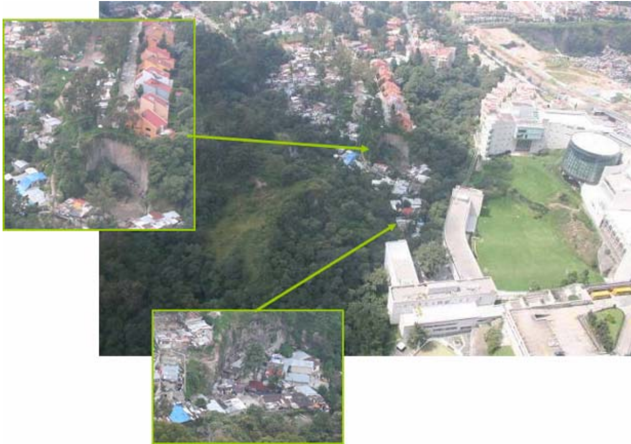
Foto 74.- En la imagen se aprecia el contraste de las construcciones de nivel económico alto, ubicadas en la parte superior de la barranca, con las viviendas irregulares que se encuentran en el cauce de la barranca y que van impactando el área verde. Varias de las viviendas irregulares están en un alto riesgo por ubicarse debajo o sobre taludes.
