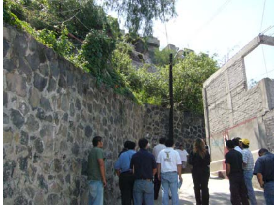
Foto 205. Muro de contención construido a lo largo de la calle Jarrito.
