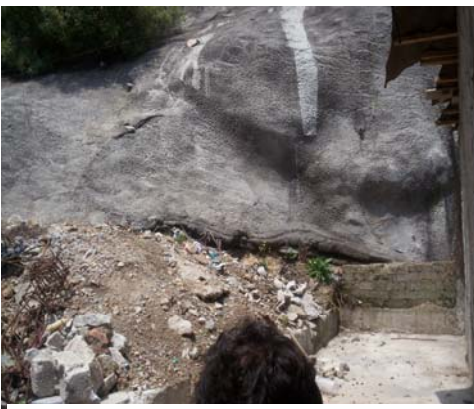
Foto 162. Colonia Malacates. Se observa parte del recubrimiento de concreto sobre el suelo del talud.
