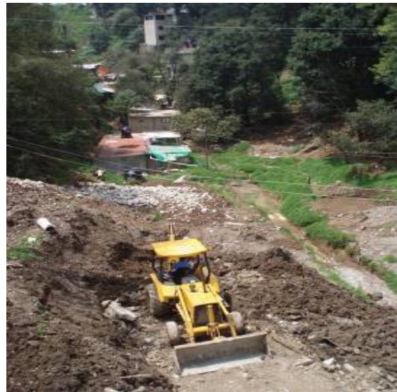
Foto 79.- Obras para la construcción de terrazas.
