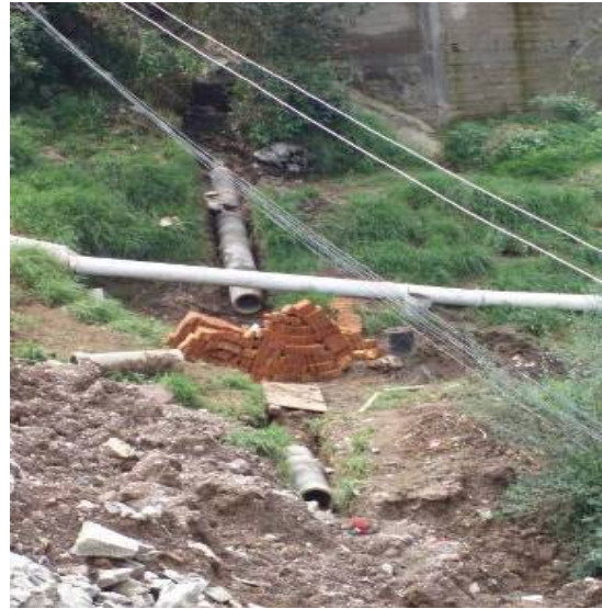
Foto 77.- Obras para introducir drenaje.
