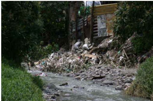
Foto 3. Deslave del talud por la corriente de agua y acumulación de residuos sólidos.
