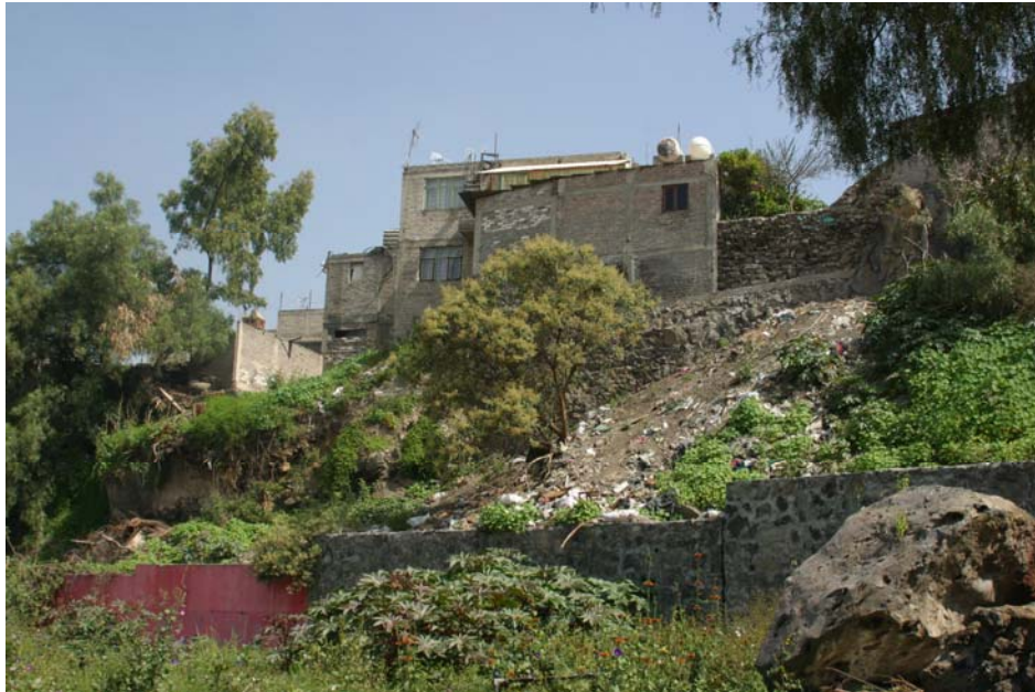
Foto 195.- Zona de riesgo en la “Barrancas de Guadalupe”
