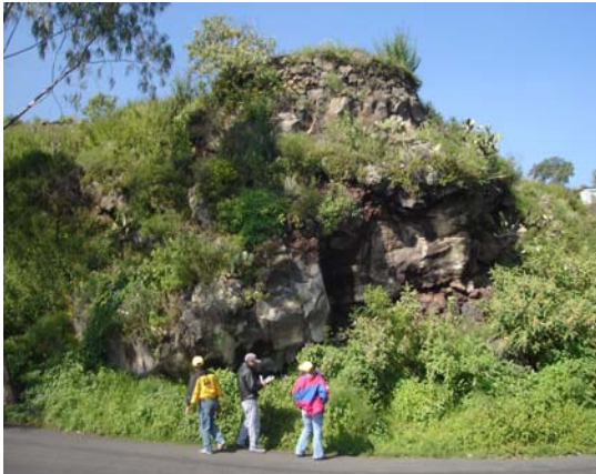
Foto 280 Talud de roca fragmentada.
