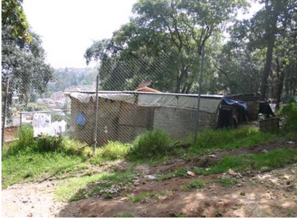
Foto 28. Asentamiento Humano que se encuentra en el talud de una barranca.
