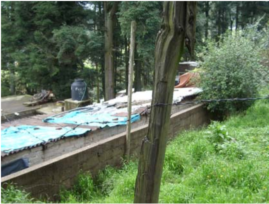
Fotos 94.- Viviendas ubicadas sobre la ladera.
