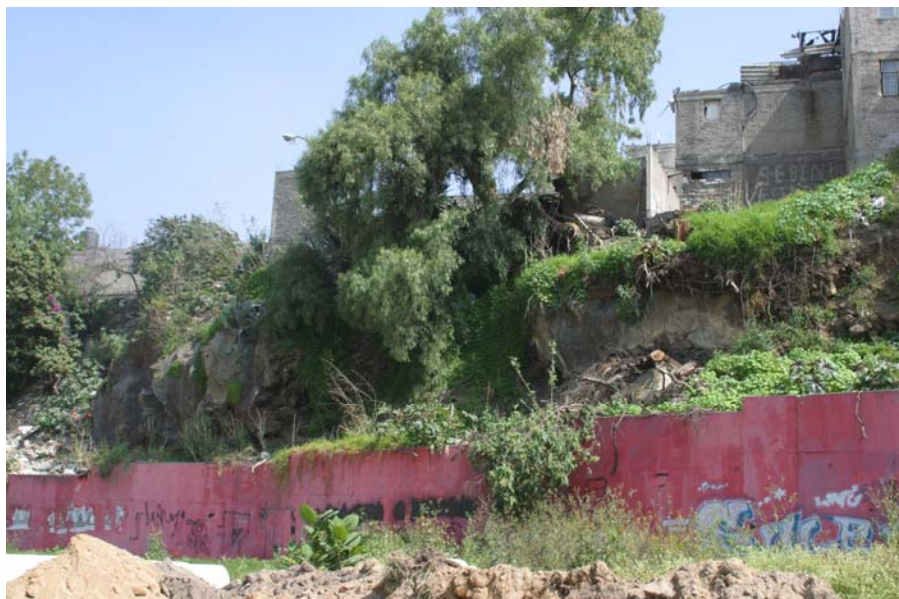
Foto 196.- Viviendas construidas sobre la ladera que se encuentran en riesgo.
