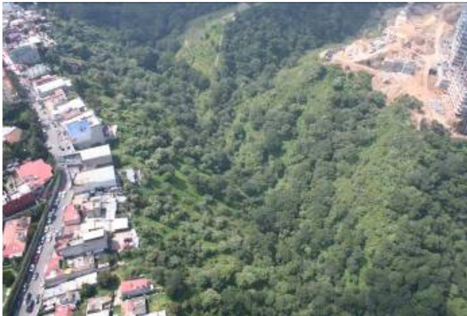
Foto 126.- Vista aérea en la que se aprecian las diversas construcciones a orillas de la barranca
