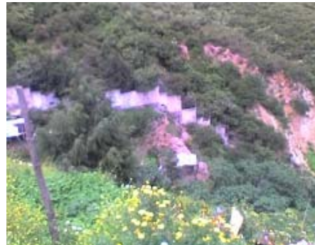
Foto 165. Barranca Abelardo Rodríguez. Viviendas ubicadas en la ladera y área en donde el suelo se encuentra erosionado.
