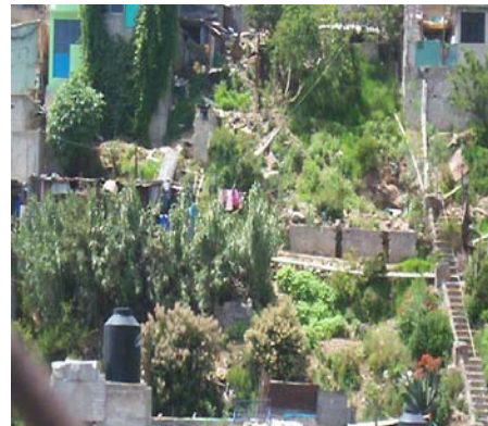
Foto 171. Barranca Armella Viviendas en riesgo por ubicarse en el talud.
