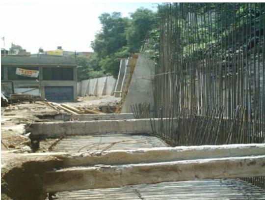
Foto 176.- Construcción del muro de construcción en “Minas o Charcas”
