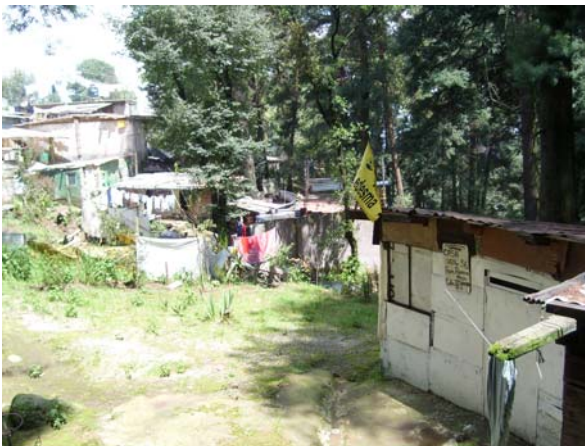
Fotos 85 y 86.- Viviendas ubicadas en la ladera
