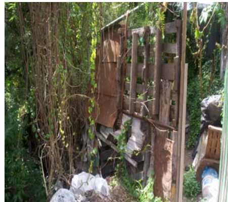
Foto 167. Felipe Berriozabal Vivienda afectada por el crecimiento del cauce.
