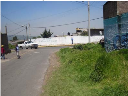
Foto 303. Viviendas construidas sobre el cauce natural
