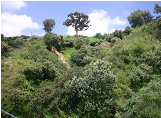
Foto 26. Deslave de talud por escurrimiento de aguas pluviales.
