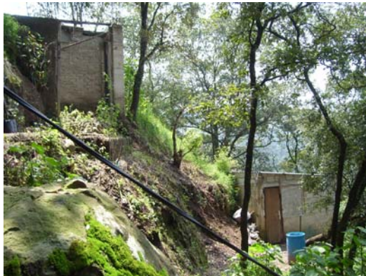
Foto 62.- Asentamientos humanos irregulares ubicados en la ladera de la barranca
