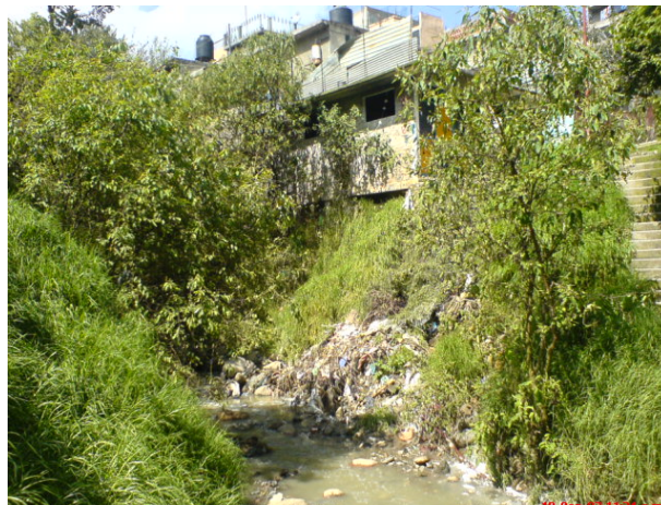
Foto 37. Riesgo de deslave e inundación por el cauce del río a las viviendas aledañas.
