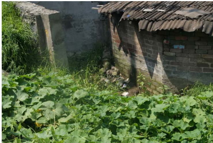
Foto 326. Vivienda ubicada en ladera de la barranca.
