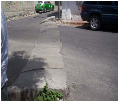
Foto 166. Felipe Berriozabal. Vista de la vialidad en donde se encuentra una tubería.
