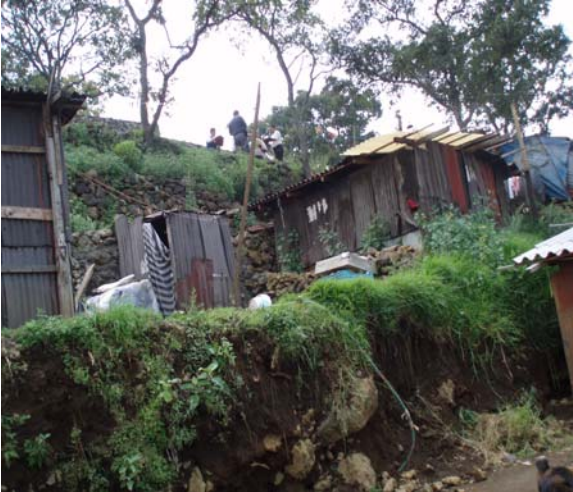
Foto 269. Terreno inestable y socavado.
