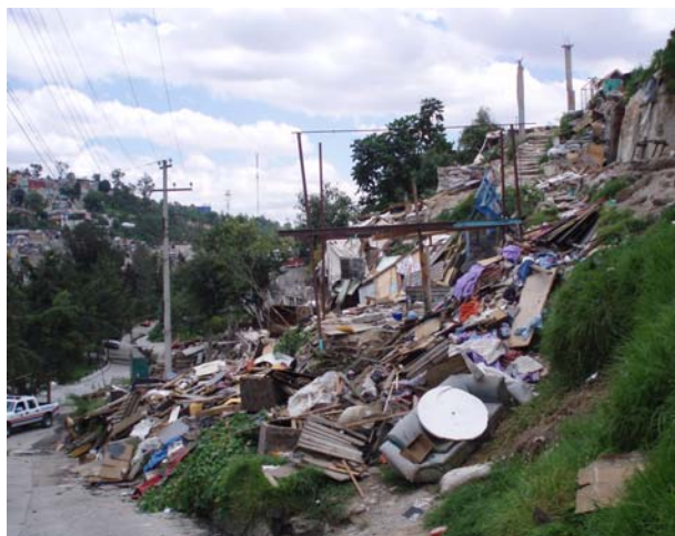
Foto 15. Deslave de talud y drenaje afectando a 23 viviendas, se observó material de una vivienda sobre la inclinación del talud (de una vivienda).
