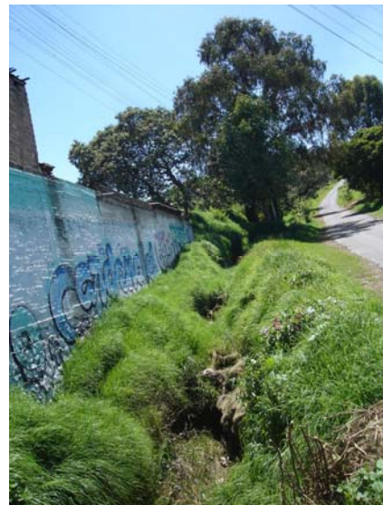
Foto 302. Cauce natural colindante con viviendas
