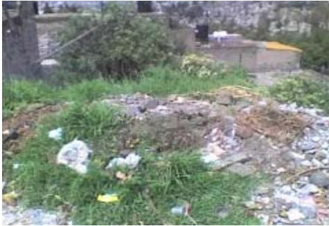
Foto 158. Arroyo Grande. Se observan residuos sólidos y cascajo en un área colindante con la barda ecológica.
