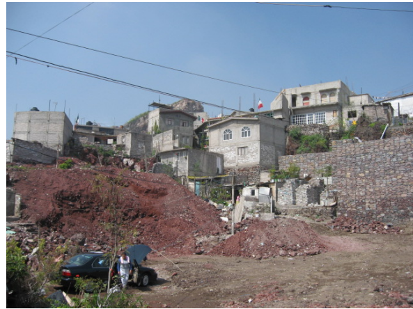
Fotos 247 y 248.- Zona en proceso de urbanización, donde se está extrayendo material propio cerro para la construcción de un proyecto del INVI.
