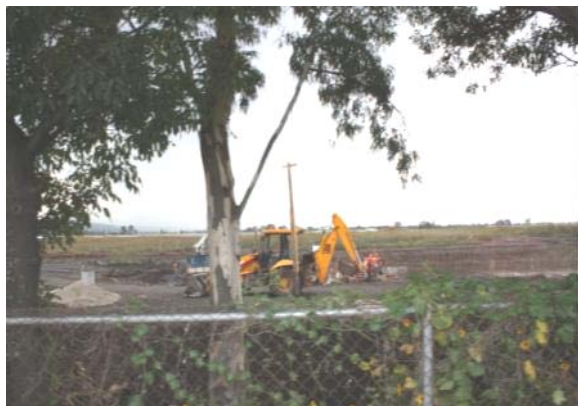
Maquinaria trabajando en la construcción de los talleres del Metro.
