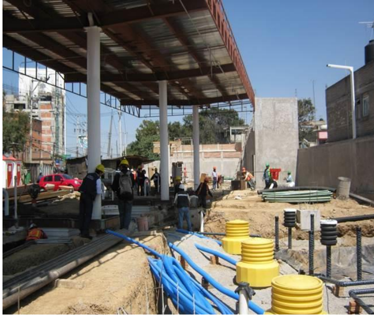
Figura 33. Estación Servicio Umbria Fuente: PAOT, 2014
