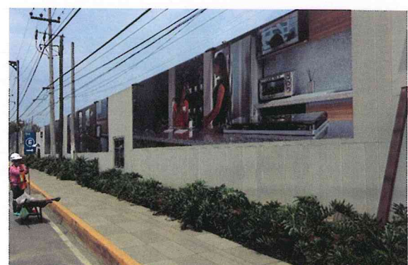
10. Carretera Federal México-Toluca 1535.- Puerta Bosques
