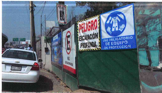
13. Carretera Federal México-Toluca 2750.- Cañada Reforma
