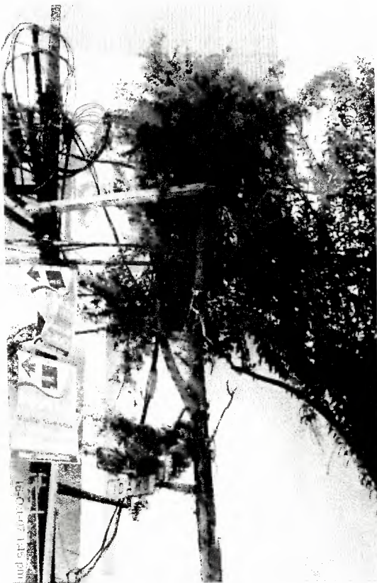
Cedro Blanco en riesgo por los cables que lo atraviesan
