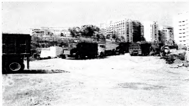
Camiones de volteo entrando y saliendo del predio
