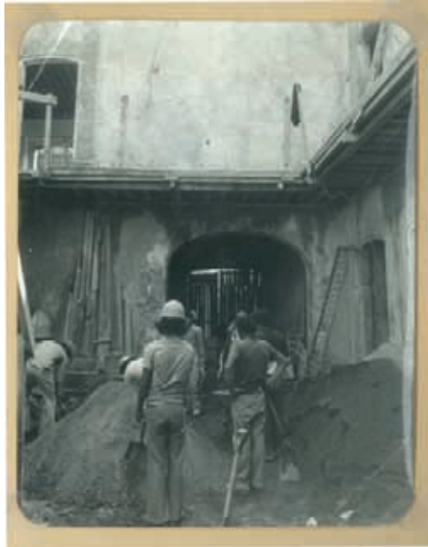
Vista de la acequia interna de la casa actual y cómo se encontraba antes de su restauración.
