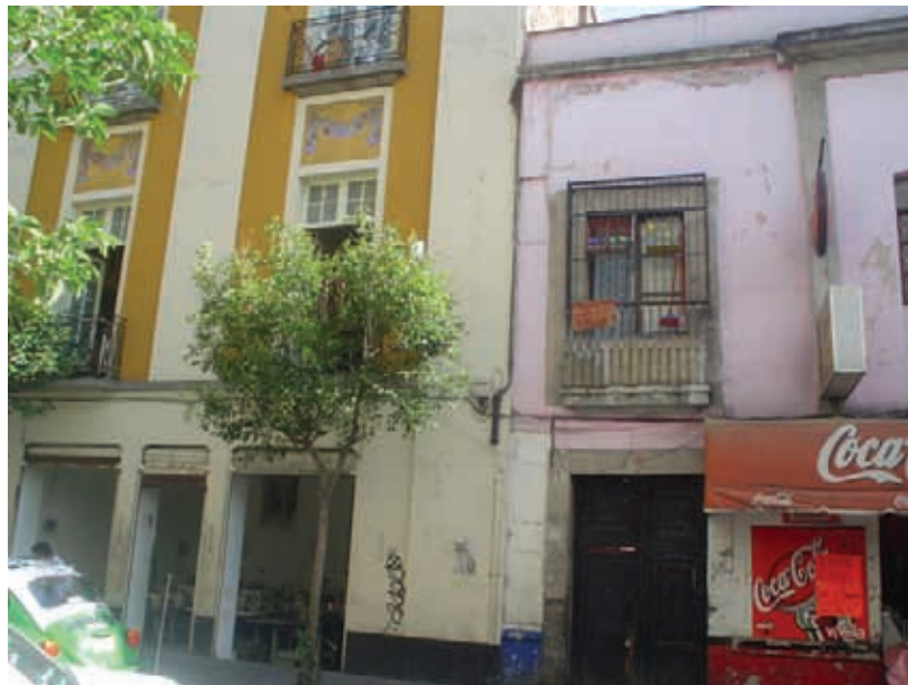
Detalle de un edificio renovado junto a una “vecindad” en el surponiente del Centro Histórico. Fotografía del autor.
